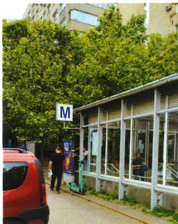
Fig. 10 – Amplasare panou de consultare stația de metrou Nicolae Grigorescu Sursă : consultant
